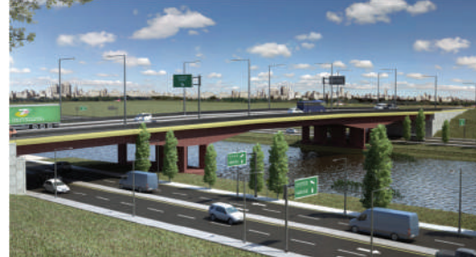
Figura 4. Futuro puente Lacarra. Fuente: AUSA, 2017.
